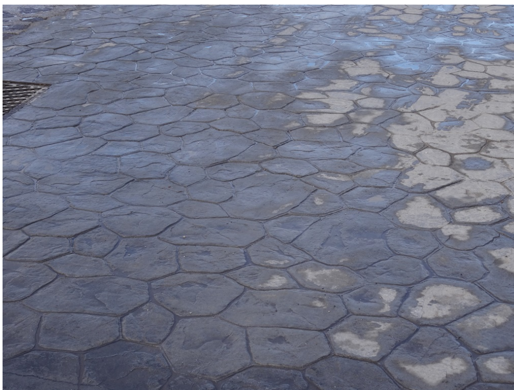
Φωτ. 4 Επιθυμητή μορφή της νέας τελικής επιφάνειας (η φωτογραφία έχει ληφθεί από άλλο σημείο του λιμένα Σκάλας Πάτμου).
