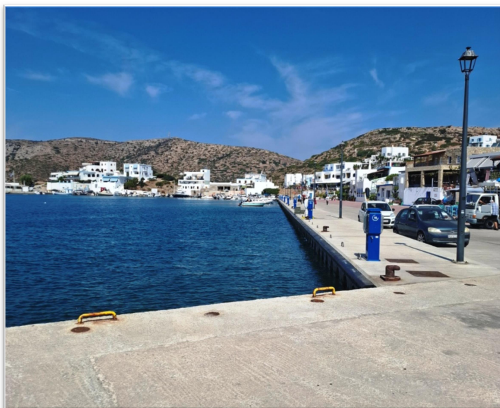
Εικόνα 23: Σημείο πρόσδεσης σκαφών στο Λιμένα των Λειψών (2024)
