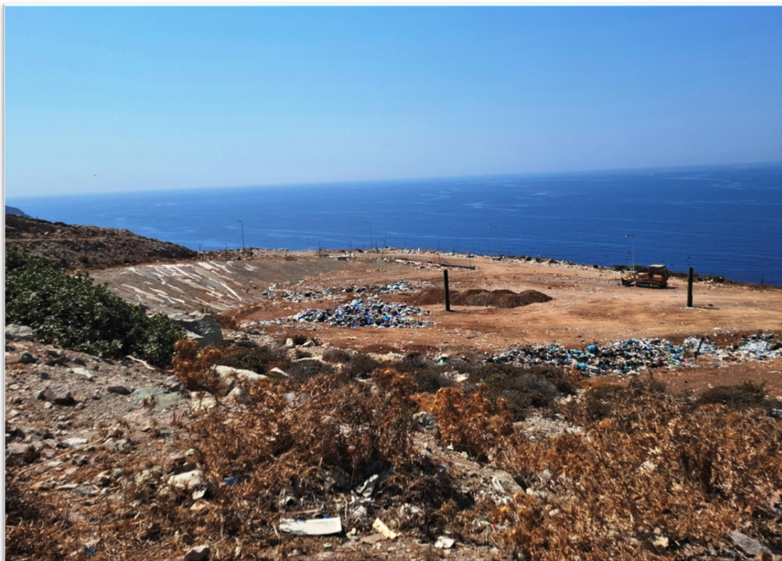
Εικόνα 32: Χώρος Υγειονομικής Ταφής Απορριμμάτων (ΧΥΤΑ) Πάτμου, ν. Πάτμου (2024)
