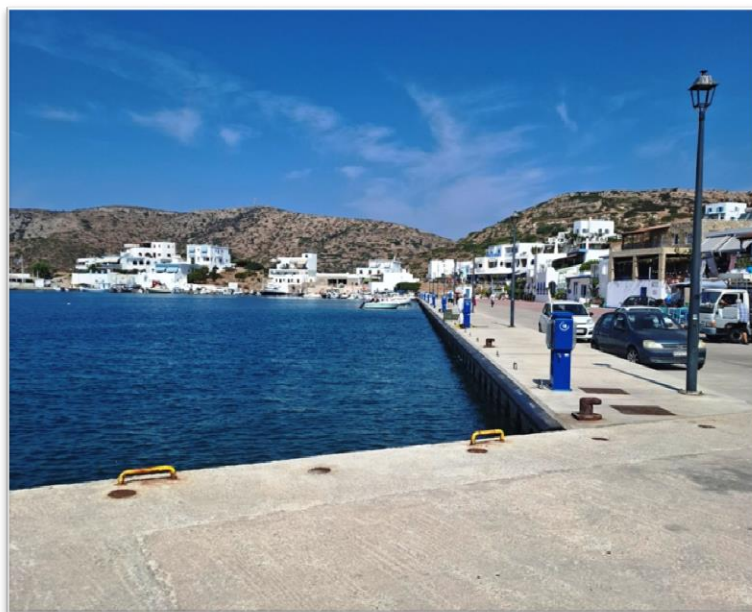
Εικόνα 23: Σημείο πρόσδεσης σκαφών στο Λιμένα των Λειψών (2024)
