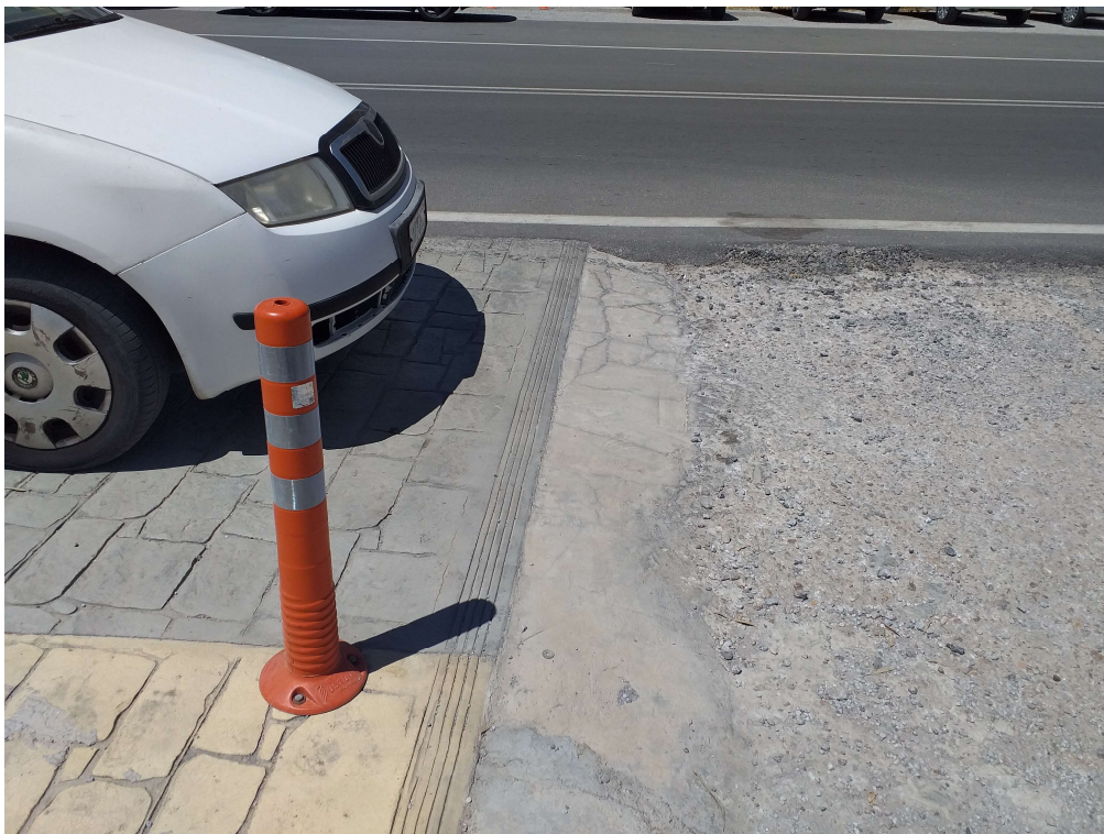
Φωτ. 3 Διαμόρφωση ράμπας στην απόληξη του έργου που κατασκευάστηκε το 2020.
