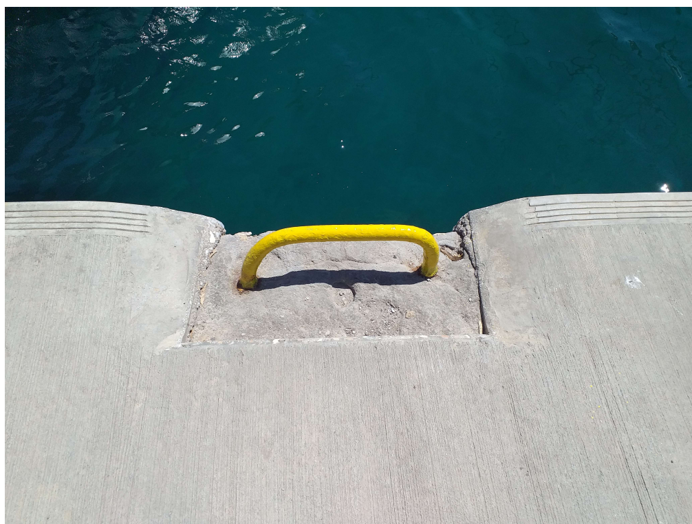
Φωτ. 6 Λεπτομέρεια διαμόρφωσης σκυροδέματος νέας επίστρωσης περίξ υφιστάμενου κρίκου πρόσδεσης.
